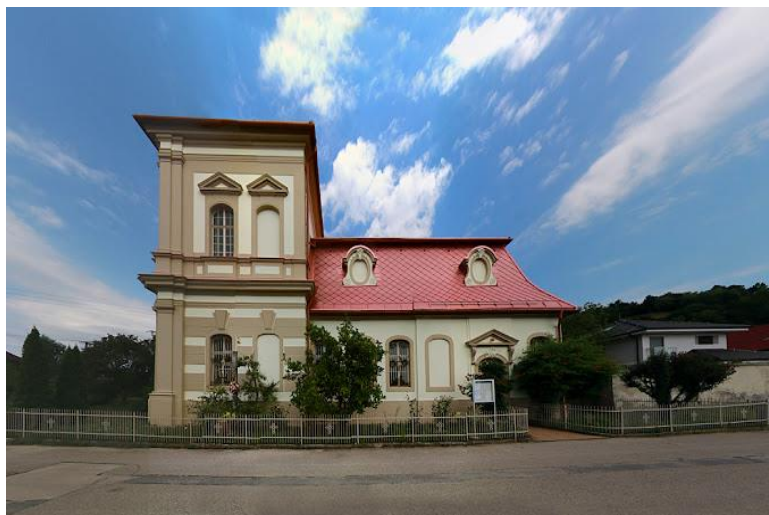
Kaplnka Nepoškvrneného počatia Panny Márie
